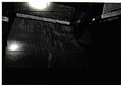
图3 轿厢护脚板向井道侧弯折
