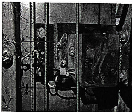
图5 门锁电气安全装置短接 图6 负1层层门副锁电气拆除
